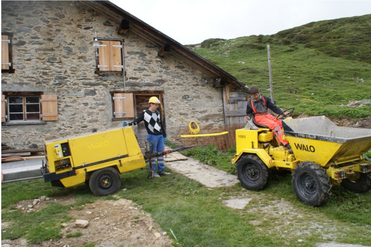
ARGE Dumper / Kompressor im Einsatz
