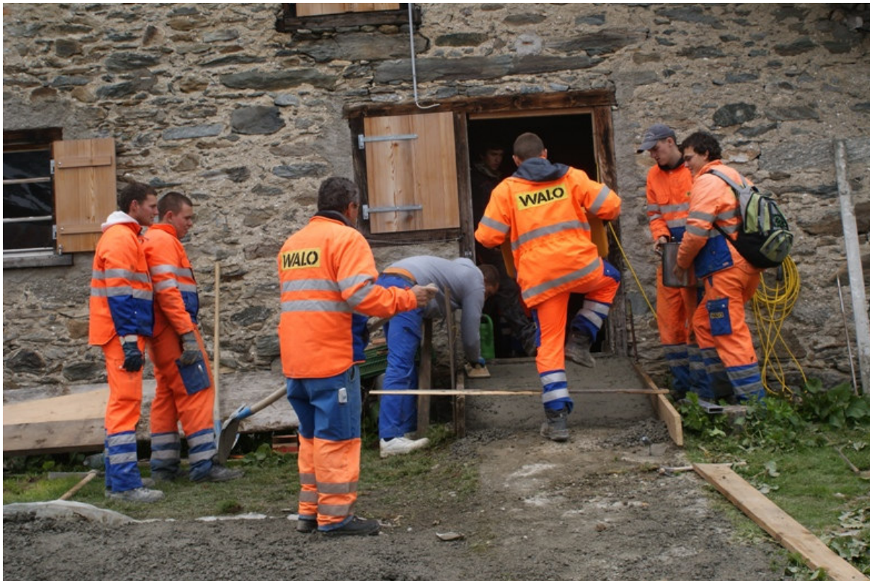
Zugang zur Alphütte betonieren....unter fachkundiger Leitung des Poliers Erwin Derungs...
