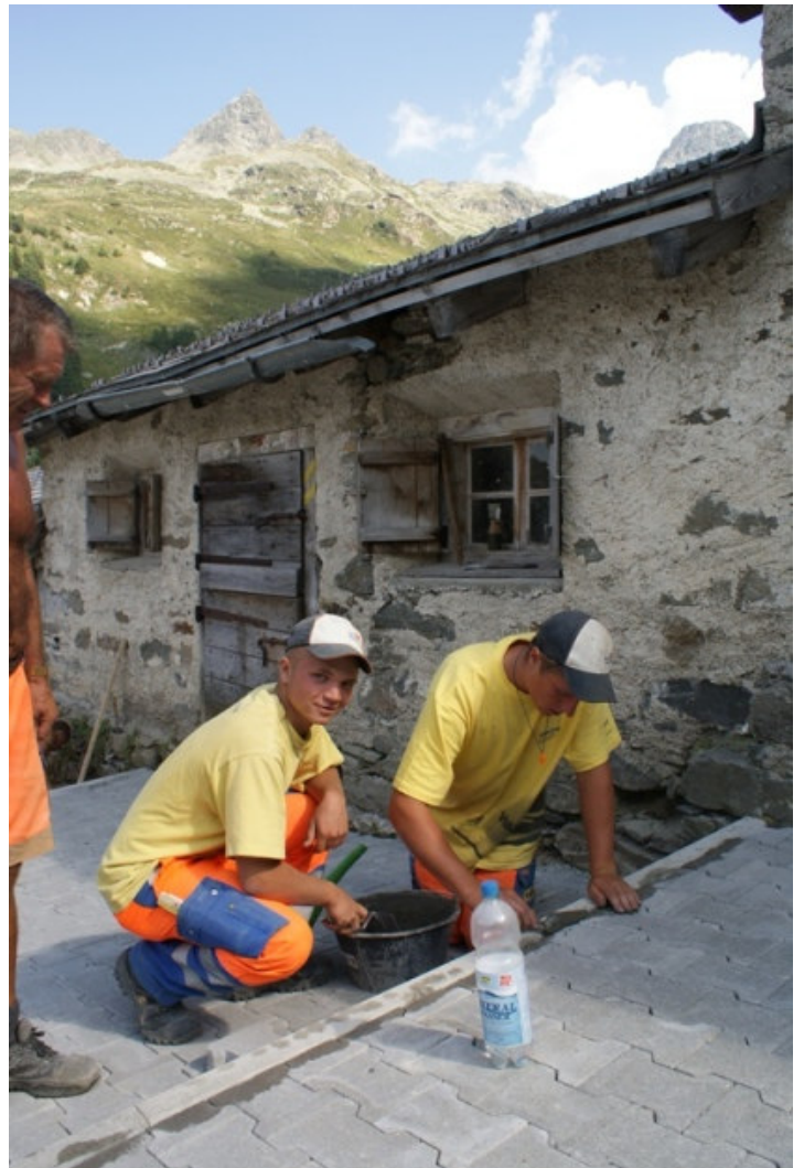
Ausfugen des Zwischenraums zwischen Verbundsteinen und Stellplatte
