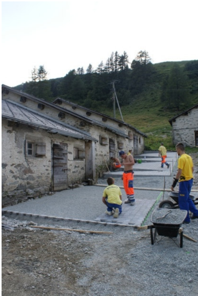
Verbundsteine verlegen vor den Ställen auf der Alp Bodmerstaffel
